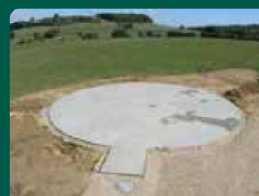
Fundação no local
