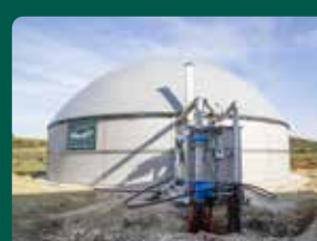
7° dia Instalação das tubulações já prontas para operação
