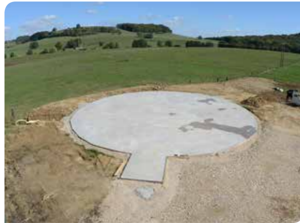
1. Tag: Vorgefertigte Bodenplatte durch den Bauherren
