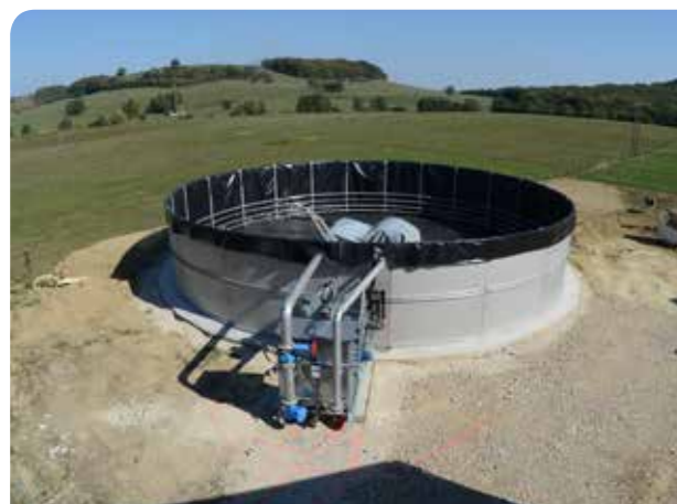
3. Tag: Fertigstellung der Technik
