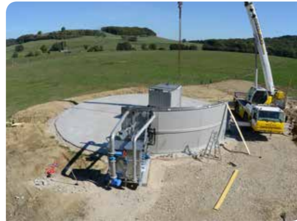
12.00 Uhr Vormittags: Stellung des Technikmodules und erster Seitenelemente
