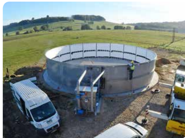
20.00 Uhr: Seitenelemente sind montiert
