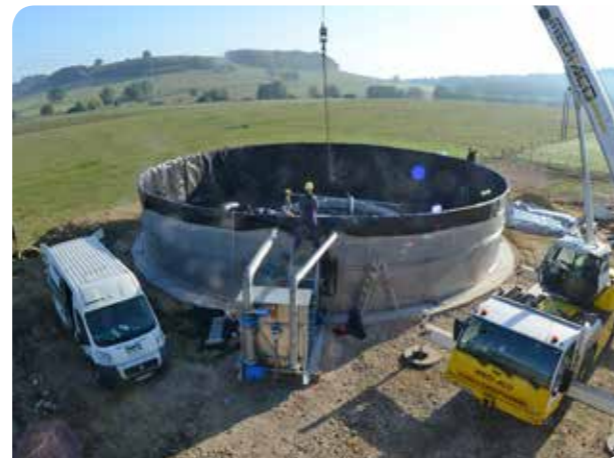
2. Tag: Innenauskleidung des Behälters
